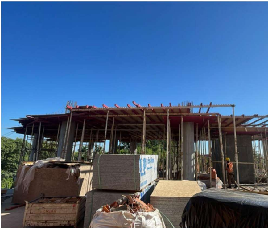
Losa N2 Torre Corporativa – Cargamento de Pilares de N2-N3 de TH2
